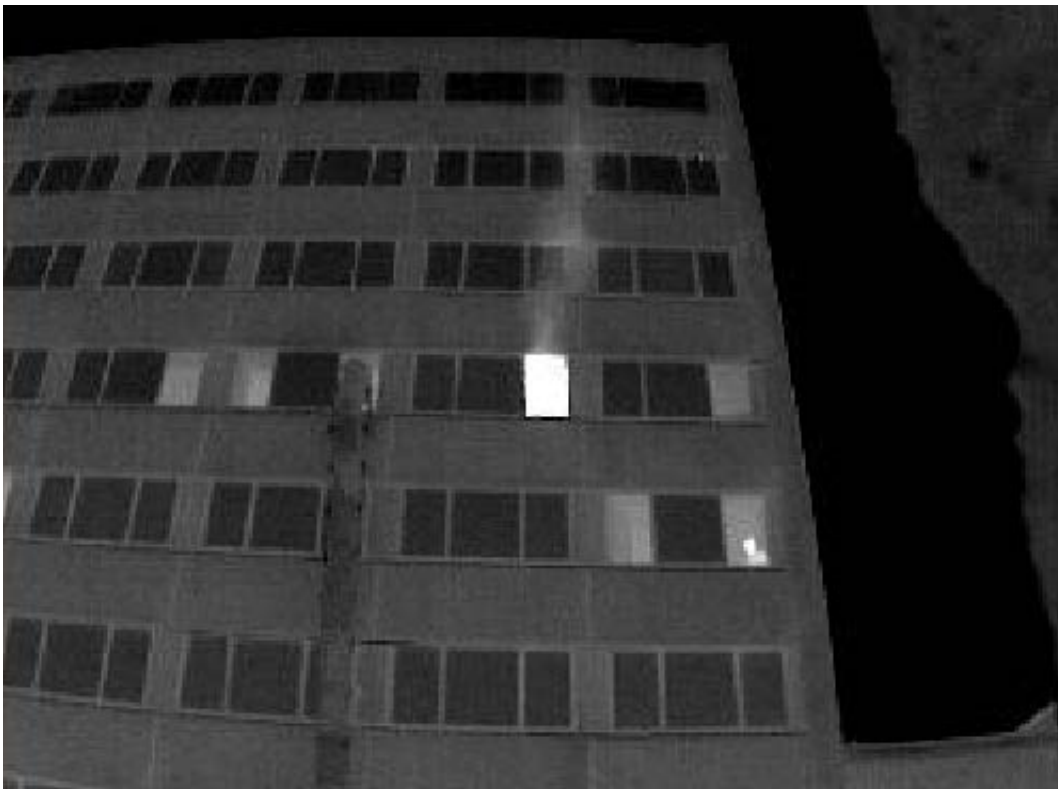
Abbildung 2.20: Die Wärmebildkamera kann für den Einsatzleiter in den meisten Fällen unterstützend wirken. Beim Blick von außen auf ein Objekt, wie zum Beispiel ein brennendes Obergeschoss eines Mehrfamilienhauses, kann durch Brandrauch oder Lichtquellen getrübt werden.
